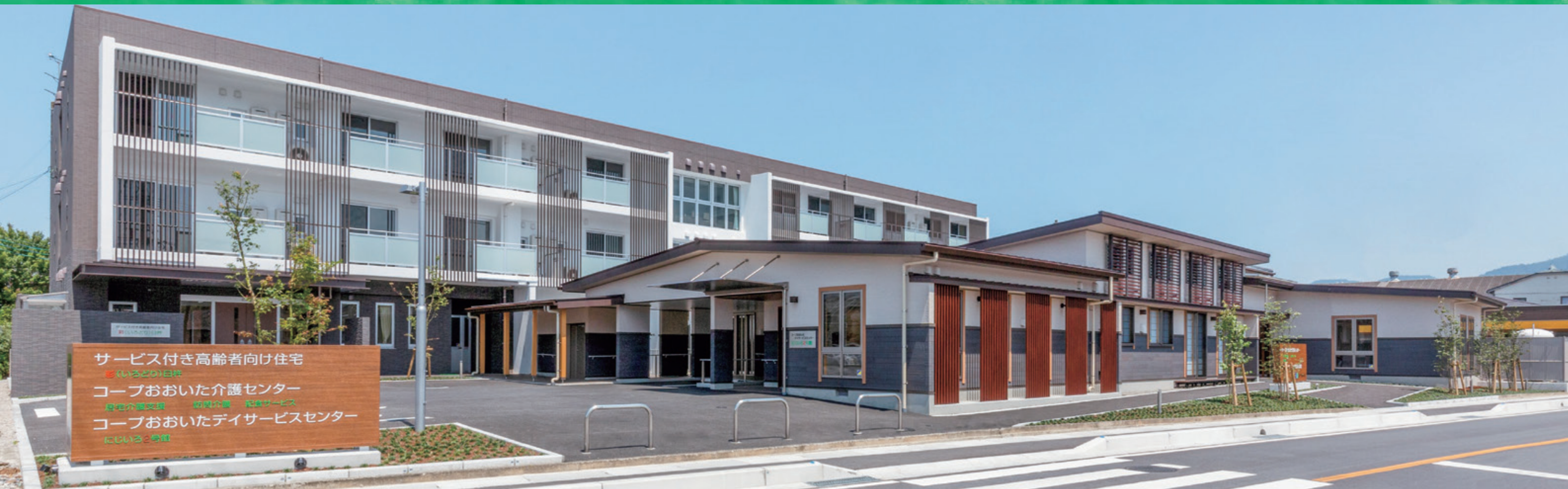
3階建て、全39戸。お部屋は広さや設備の異なる4タイプ。
