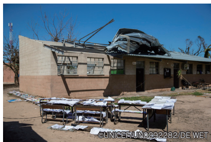
©UNICEF/UN0292282/DE WET サイクロンによって屋根が完全に破壊されたモザンビーク・ペイラ地域の中学校。教科書も水浸しになった。(3月25日)
