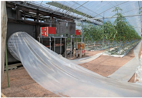
奥が炭酸ガス発生装置で、手前がダクトを接続した暖房。
