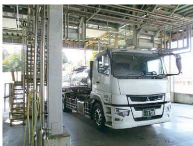
タンクローリー車で運ばれてきた生乳は受入検査を行い、合格したものを工場に受け入れている。
