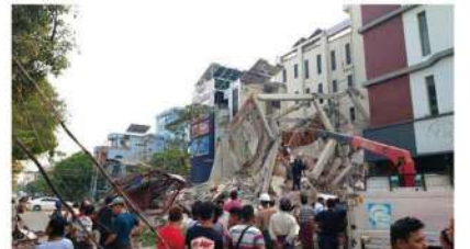
©UNICEF/UNI770508/anonymous 地震の影響で倒壊した建物。 (ミャンマー中部マンダレー、2025年3月29日撮影)
