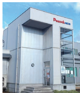
新潟県長岡市にある『(株)ピーコック』の小国工場。
